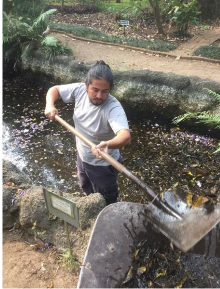
Anexo 10. Limpieza del Estanque, extrayendo materia sólida
