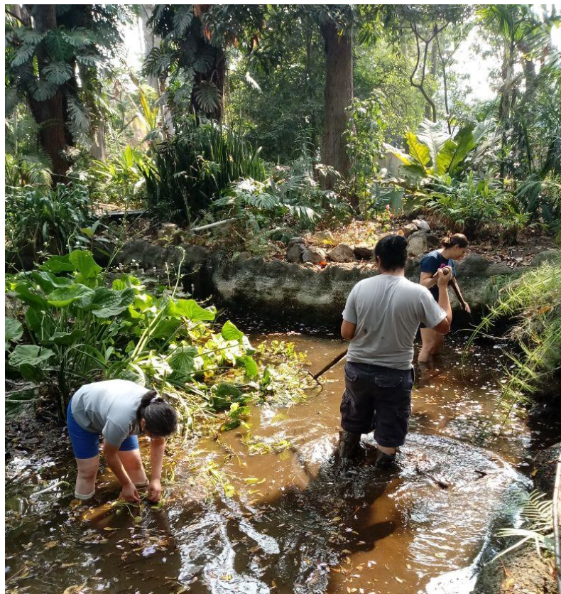
Anexo 11. Limpieza del Estanque, extrayendo materia sólida
